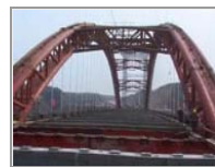
郧县汉江大桥实现南北两岸贯通
